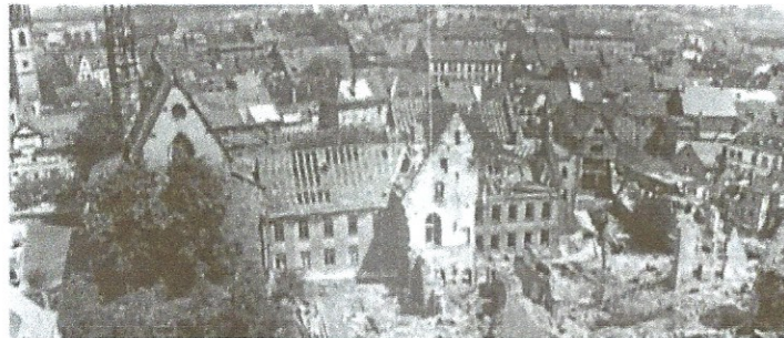
In den Wochen vor dem 25. Februar 1945 nahmen Luftangriffe auf Erfurt weiter zu. Der Keller unterhalb des Bibliotheksgebäudes im Augustinerkloster galt als sicherer Luftschutzbunker.
