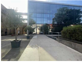
Seminargebäude und Zugang zum Raum der Stille
