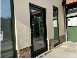
Tür zum WC-Gebäude
